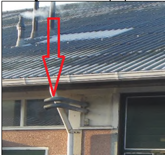
Afbeelding 4.1: uitlaten vacuümpomp melkmachine
